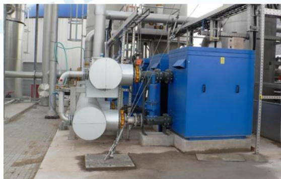
Новые винтовые воздуходувки Lutos предлагают комплексное решение, в которое входит винтовой элемент повышенной эффективности, TEFC IP55 электродвигатель, редуктор. Конструкция без проблем переносит транспортировку и рассчитана на простую установку на объекте. Благодаря новым технологиям существенно снижен уровень шума при эксплуатации.
